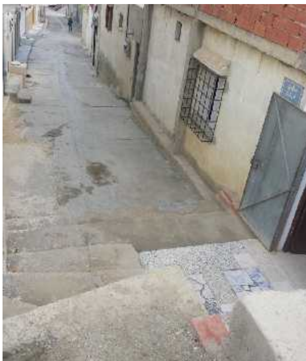
Figure 6: phénomène de stagnation des eaux pluviale
