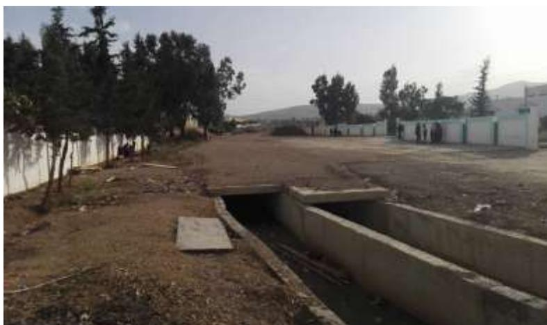
*Figure 10 : Dalots de drainage des eaux pluviales*
