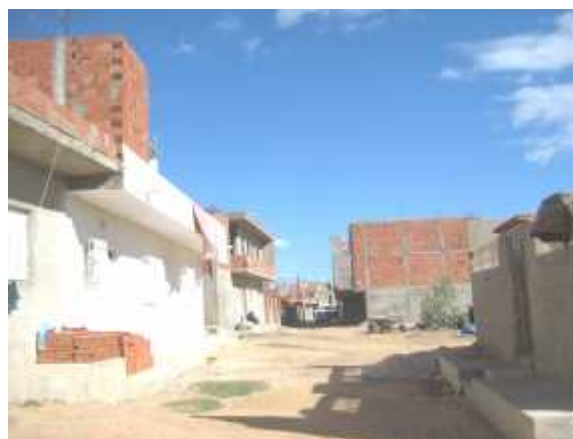
Zone du quartier non desservie par le réseau d'assainissement
