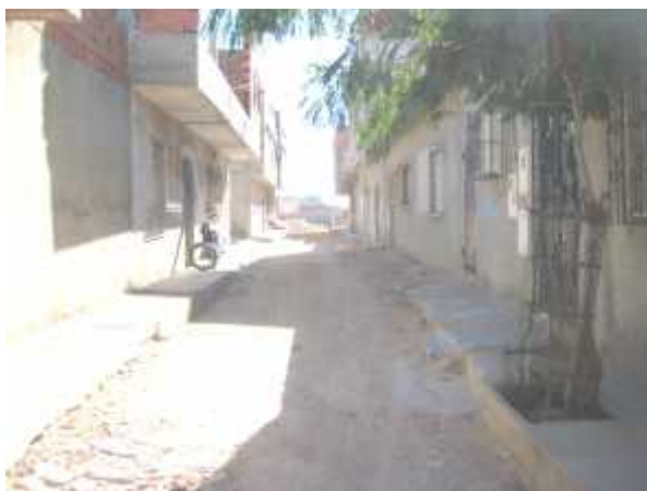
Exemple de dépassement des emprises de voirie
