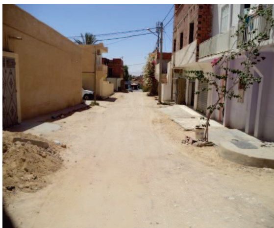
Présence d'ordure de ménagères dans l'emprise.
