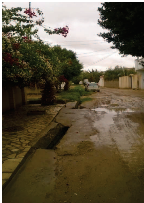
Canal d'irrigation dans l'emprise.
