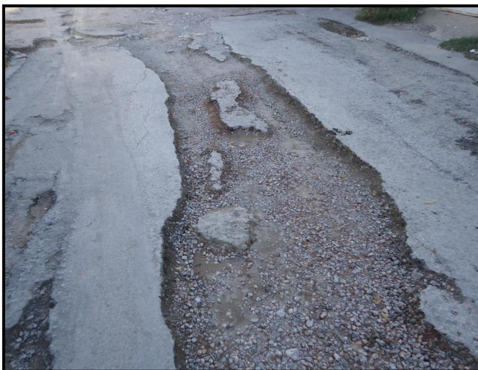
Photo N° 3: Voie en dégradation avancée à cause d'écoulement des eaux pluviales
