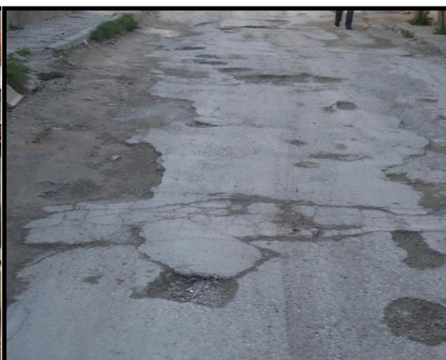
Photo N° 2: Chaussée en béton bitumineux très dégradée
