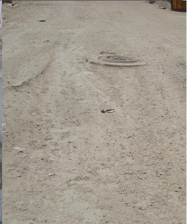
Photo N° 9: Contre voie de la RN2 chaussée en bicouche dégradée à cause des travaux d'assainissement
