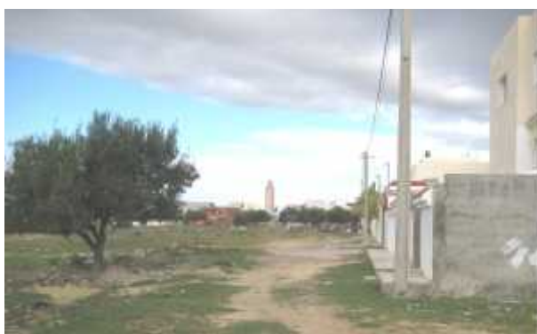
Poteaux d'alimentation en électricité
