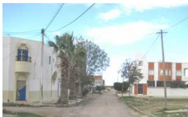
Poteau équipé d'un luminaire
