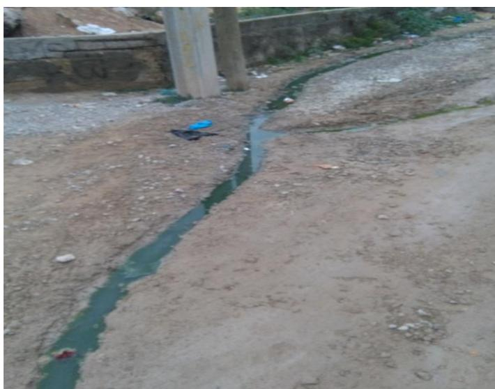
**Figure 12 : Ecoulement des eaux usées le long des voies du quartier**
