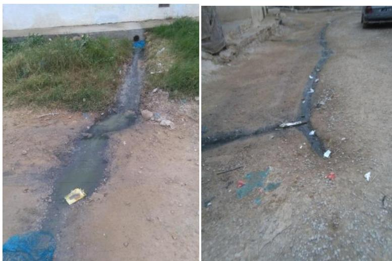
**Figure 11 : Sortie des eaux usées d'un logement dans la voirie**
