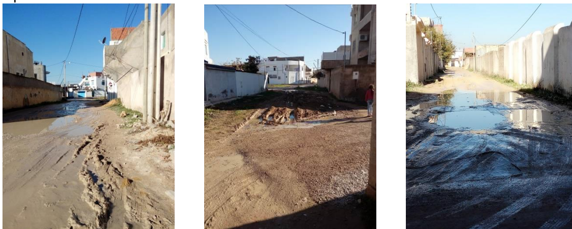
Figure 2-11 : État actuel de l'assainissement des eaux pluviales dans le quartier Brarja
