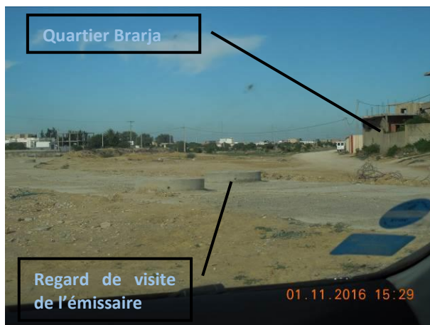
Emissaire de la STEP Choutrana (enterré)
