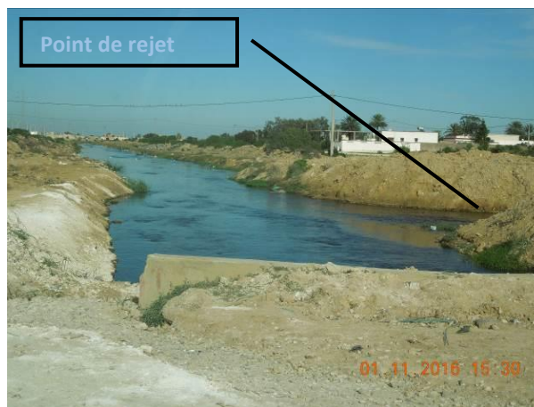
Point de rejet de l'émissaire dans le Canal El Khélij
