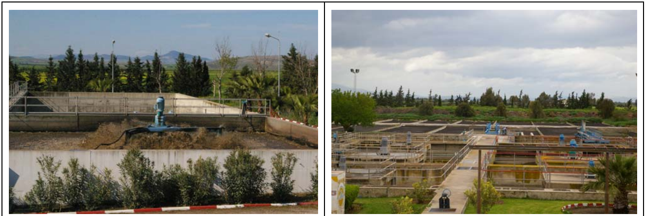
Figure 7-1 Aérateur de surface dans les STEP du Kef et de Jendouba
