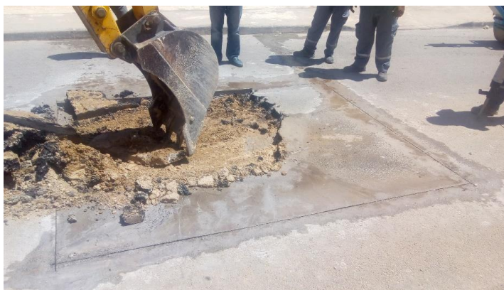
Décaissement à la tractopelle
