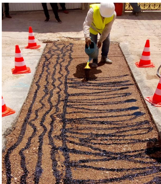
Répandage du liant à l'aide d'un arrosoir
