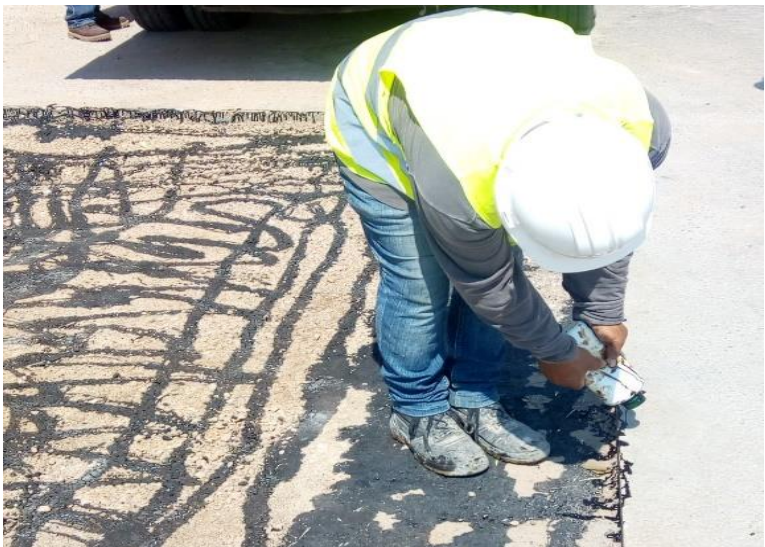
Répandage de l'émulsion sur les parois
