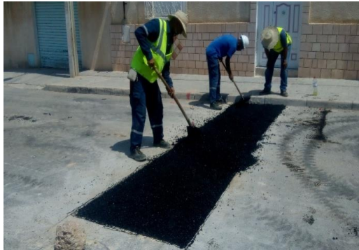
Mise en place de l'enrobé
