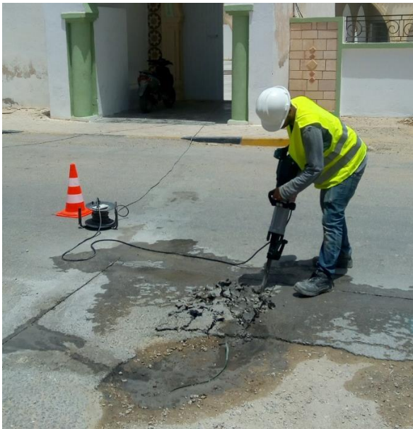
Démolition de la couche de roulement au marteau piqueur
