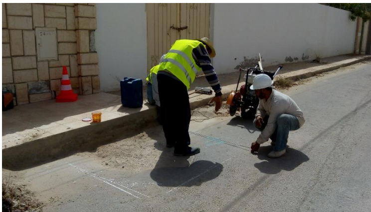
Opération de traçage
