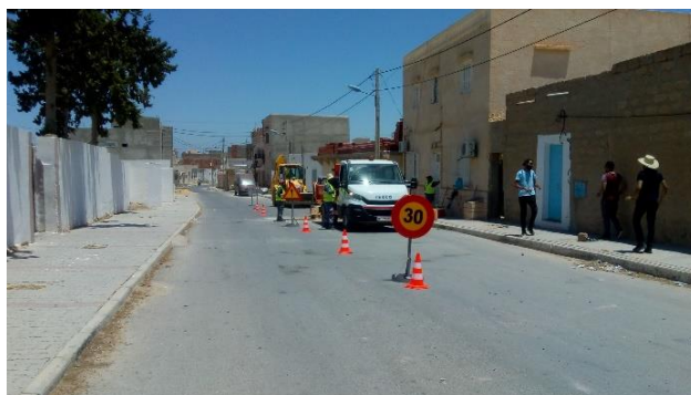
Signalisation mise en place en amont, le long et en aval de la zone d'intervention
