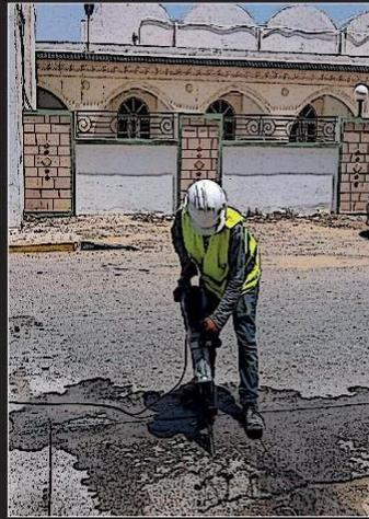
Equarrissement, évacuation des matériaux impropres et soufflage
