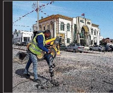
Enlèvement, évacuation des matériaux impropres et soufflage
