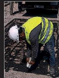
Arrosage à l'émulsion de bitume au niveau des bords pour assurer la liaison
