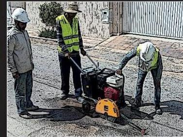
Repérage de la zone, découpage mécanique en forme géométrique et à bords verticales
