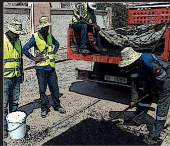
Mise en place de la couche de roulement
