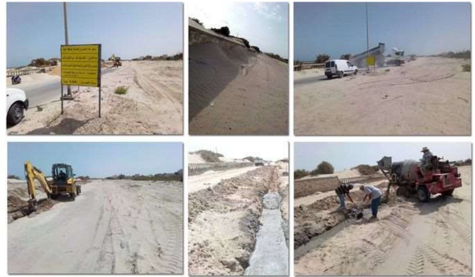
إنطلاق أشغال تهيئة الفسحة الشاطئية بكورنيش قابس
